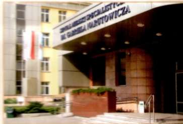
Termomodernizacja budynku Szpitala Specjalistycznego im. G. Narutowicza w Krakowie.
