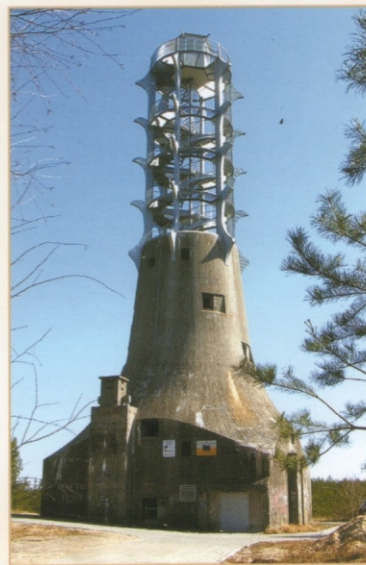
Adaptacja Wieży Baterii Nabrzeżnej „GOEBEN” na cele turystyczne w Świnoujściu-Przytór.
