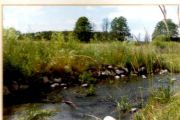
Modernizacja rzeki Świąćek w Nadleśnictwie Drygały.
