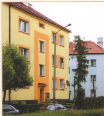
Termomodernizacja 89 budynków w gminie Czerwionka-Leszczyny.
