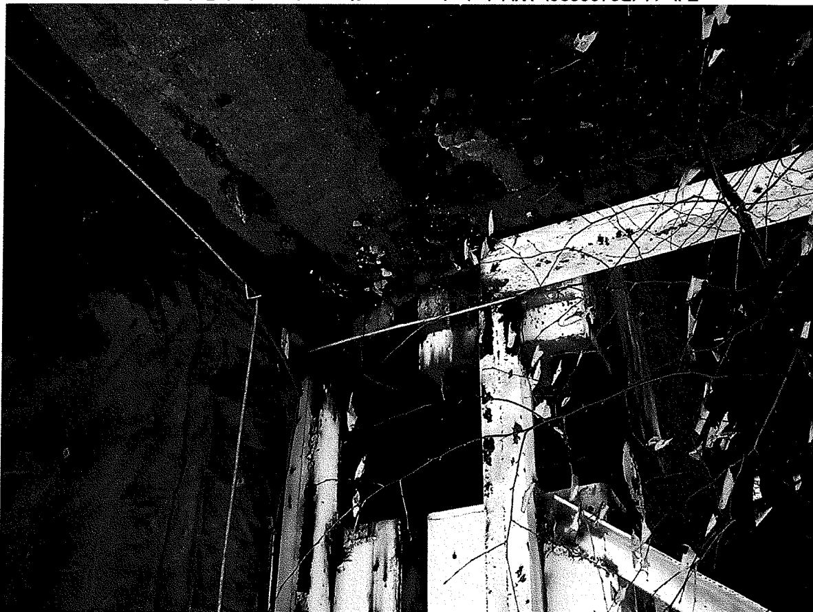
Zdjęcie 41 (P3180028) Widok dachu nawy północnej w osiach B do C - oś C 16 i 17 - brak murków ogniwowych i obróbek blacharskich, niezabezpieczona konstrukcja przeszkleń-
