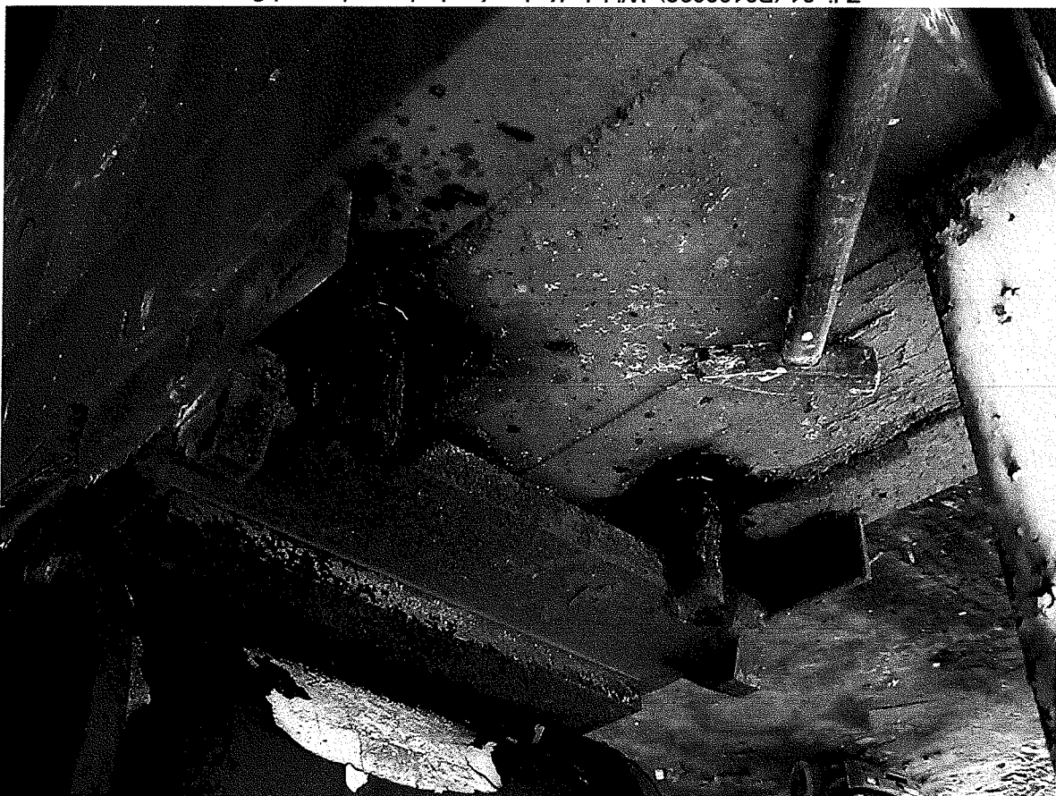
Zdj. 31 (P3180026) Widok dźwigarów dachowych w osi C - widok łożyska dźwigarów w osi 18- mocno skorodowane pręty kotwiące \phi 32mm -
