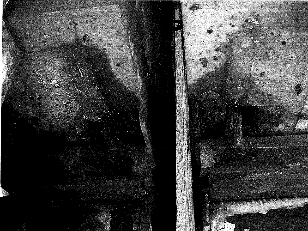
Zdj. 31 (P3180026) Widok dźwigarów dachowych w osi C - widok łożyska dźwigarów w osi 18- mocno skorodowane pręty kotwiące \phi 32mm -
