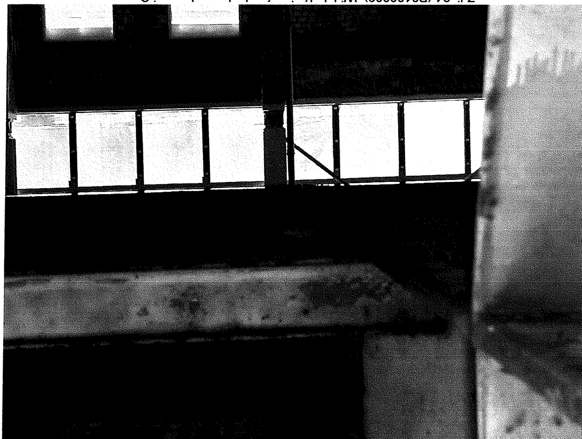
Zdj. 23 (P3180006) Widok dźwigarów dachowych w osi C - widok dźwigara dachowego w osi 24 – niewielkie trwałe ugięcie –
