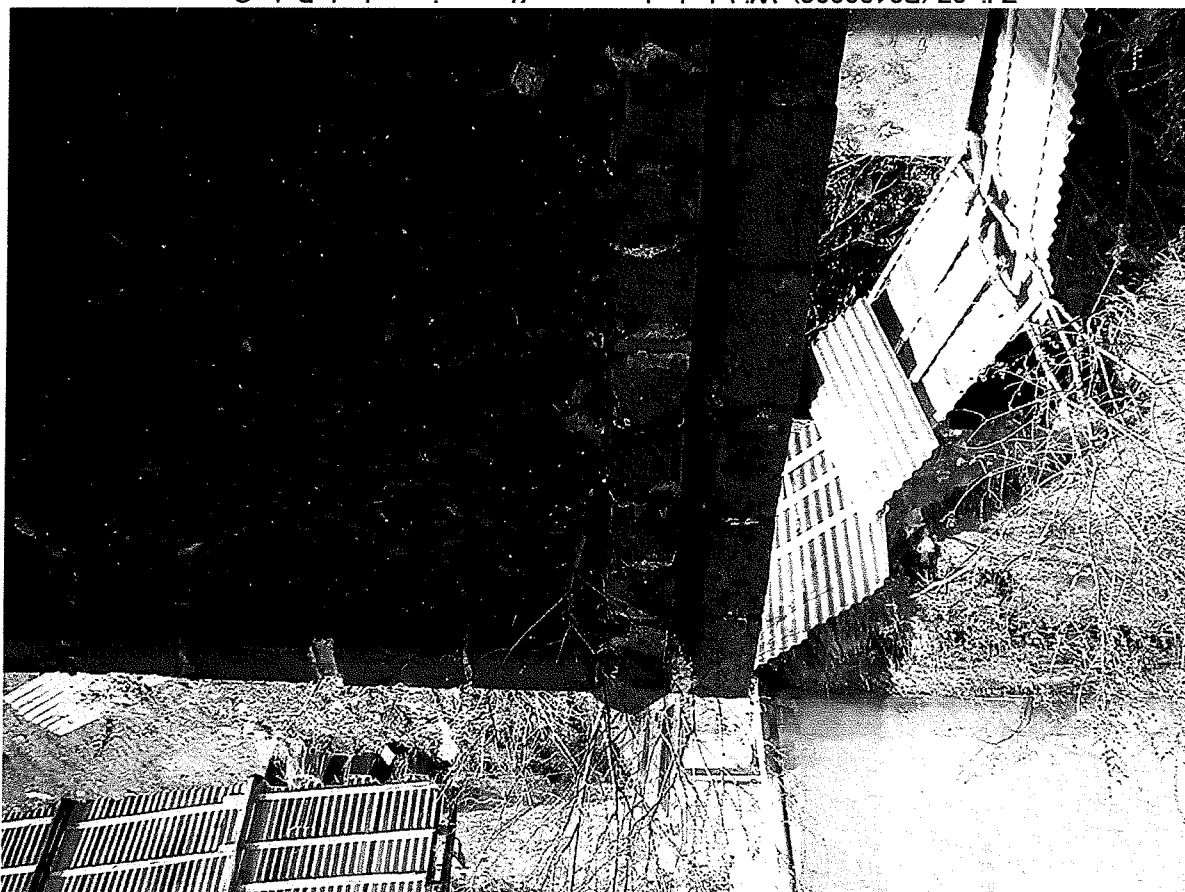
Zdj. 37 (P3180006) Widok dachu nawy północnej w osiach B do C - widok narożnika w części wschodniej oś B 24 – brak murków ogniowych i obrbek blacharskich –
