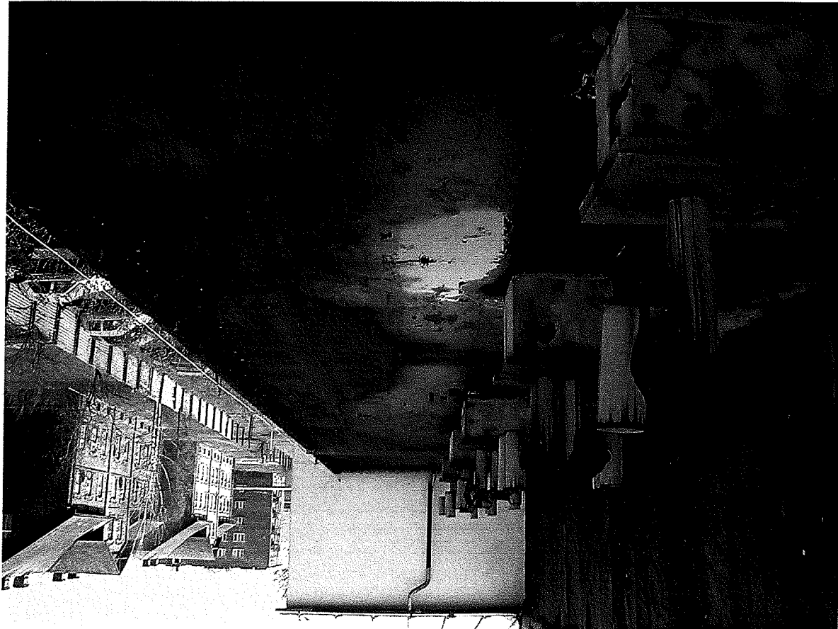
Zdjęcie 41 (P3180028) Widok dachu nawy północnej w osiach B do C - oś C 16 i 17 - brak murków ogniwowych i obróbek blacharskich, niezabezpieczona konstrukcja przeszkleń-
