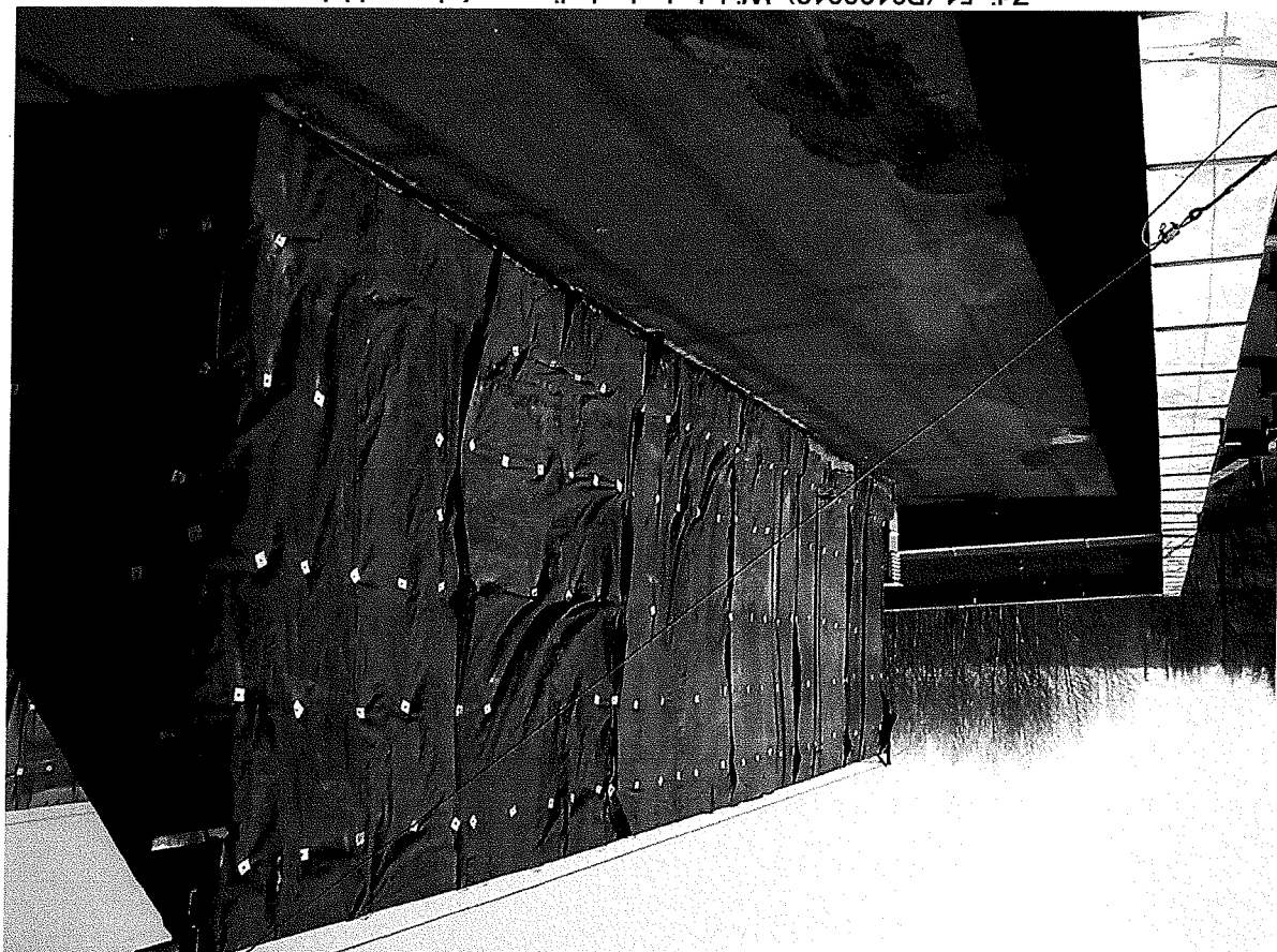
Zdj. 51 (P3180012) Widok dachu hali w części wysokiej - widok świetlików dachowych zabezpieczonych przed deszczem -
