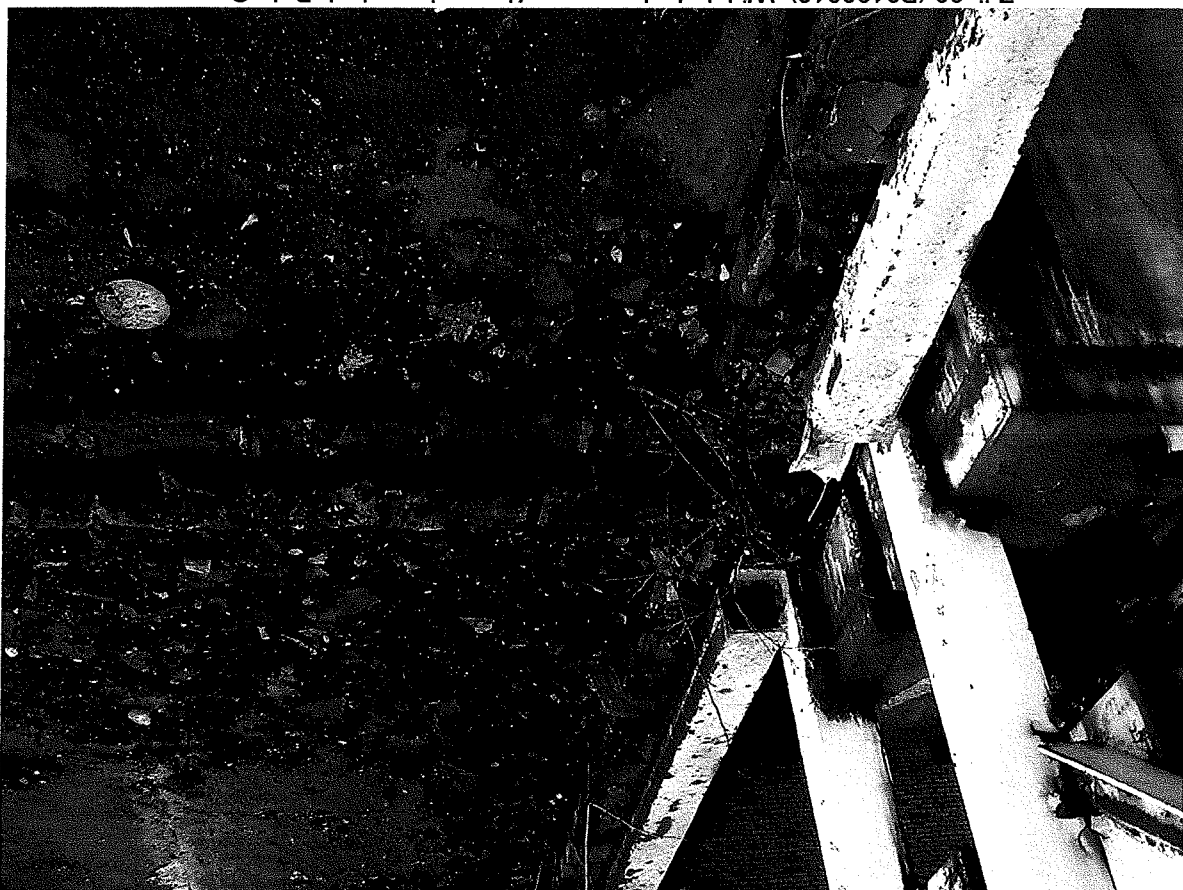
Zdj. 39 (P3180016) Widok dachu nawy północnej w osiach B do C -oś C 20 i 21-brak murków dylatacyjnych i obróbek blacharskich, niezabezpieczona konstrukcja przeszkleń-
