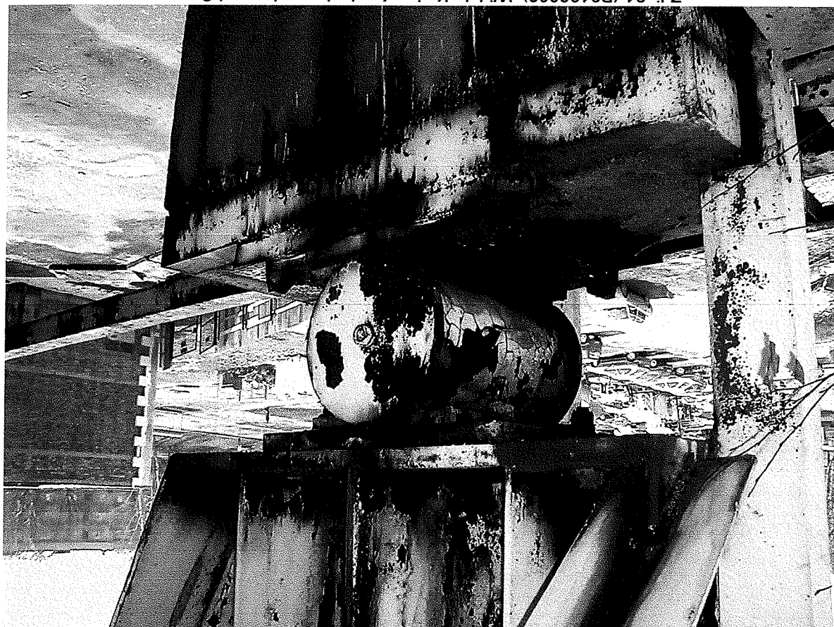
Zdj. 21 (P3180003) Widok dźwigarów dachowych w osi C - widok łózyska dźwigarów w osi 24 -
