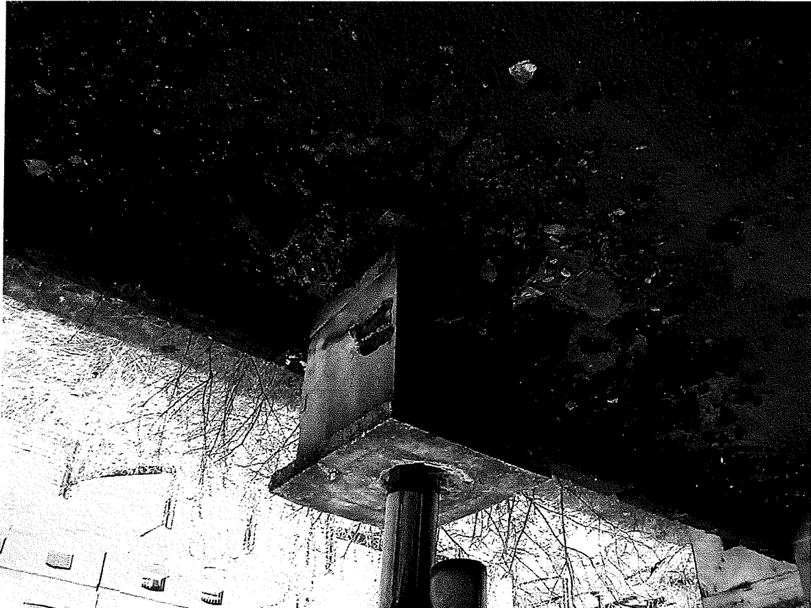
Zdj. 39 (P3180016) Widok dachu nawy północnej w osiach B do C -oś C 20 i 21-brak murków dylatacyjnych i obróbek blacharskich, niezabezpieczona konstrukcja przeszkleń-
