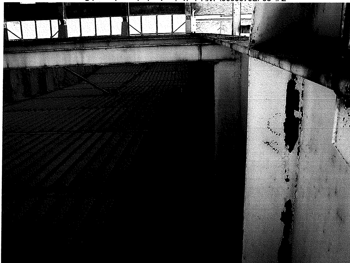
Zdj. 23 (P3180006) Widok dźwigarów dachowych w osi C - widok dźwigara dachowego w osi 24 – niewielkie trwałe ugięcie –
