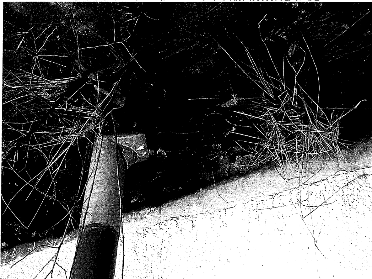
Zdjęcie 43 (P3180033) Widok dachu nawy północnej w osiach A do C - oś B 11 – widok zniszczonej papy przy ruście spustowej z daszku klatki schodowej do kosza dachowego-
