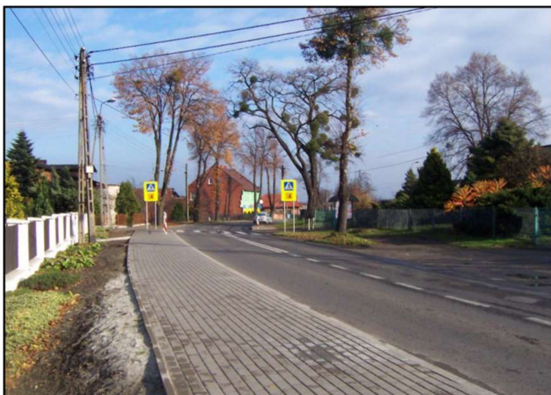
Ulica ks. Pojdy – widok w kierunku Szczygłowic
